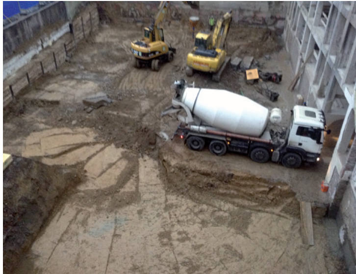
Baugrube, rechts die Rückfassade der Zweigertstraße 36
