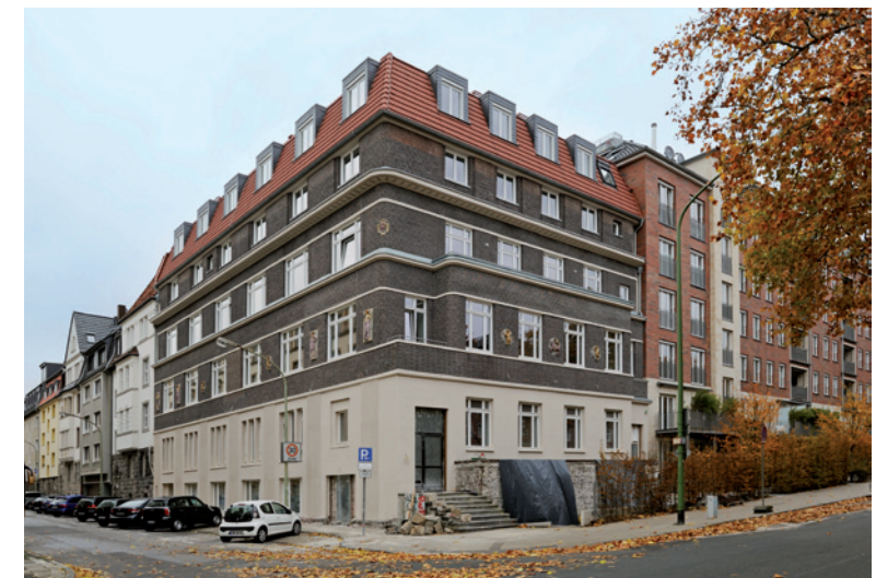
Fertige Fassade Zweigertstraße 50: Kanzleihaus Salomon Heinemann
