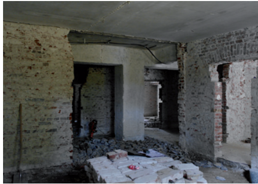
Baustelle Zweigertstraße 50, innen
