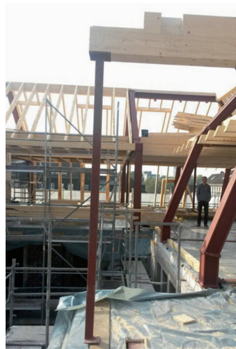
Neuer Dachstuhl Zweigertstraße 50 / Kortumstraße 41
