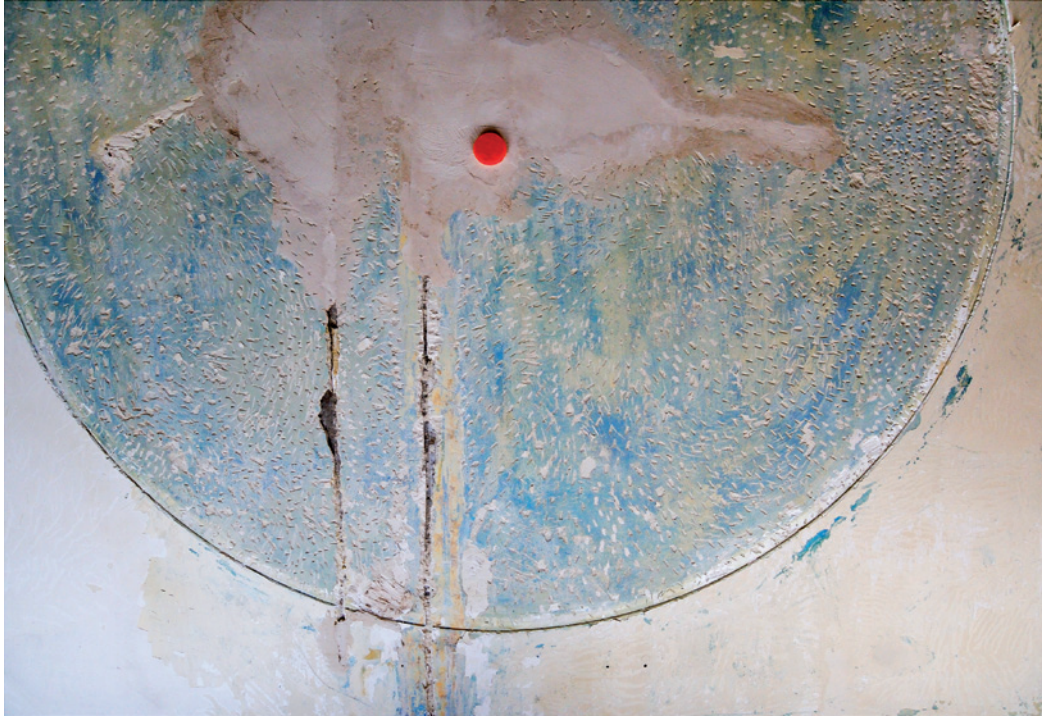
Baustelle Zweigertstraße 50, freigelegter Stuck
