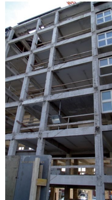
Entkernte Rückfassade Zweigertstraße 36 während der Bauphase
