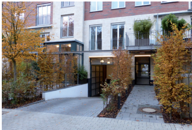
Detail Eingang Tiefgarage
