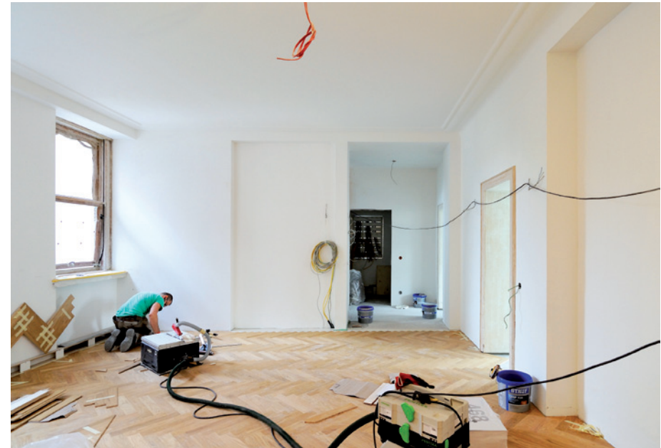
Baustelle Zweigertstraße 50, Parkettarbeiten
