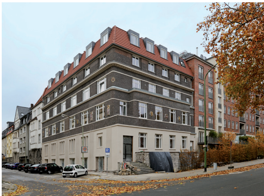
Fertige Fassade Zweigertstraße 50
