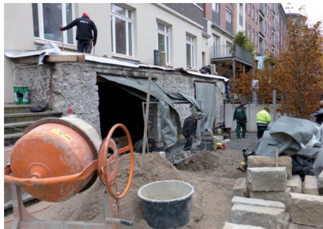
Baustelle Zweigertstraße 50, außen
