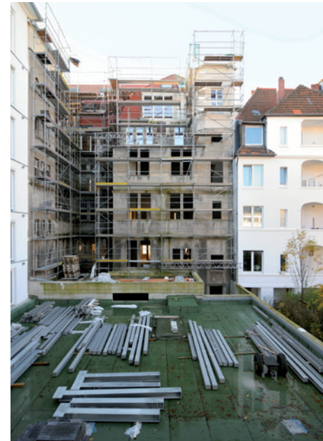
Rückfassade Zweigertstraße 50 / Kortumstraße 41, Baustelle
