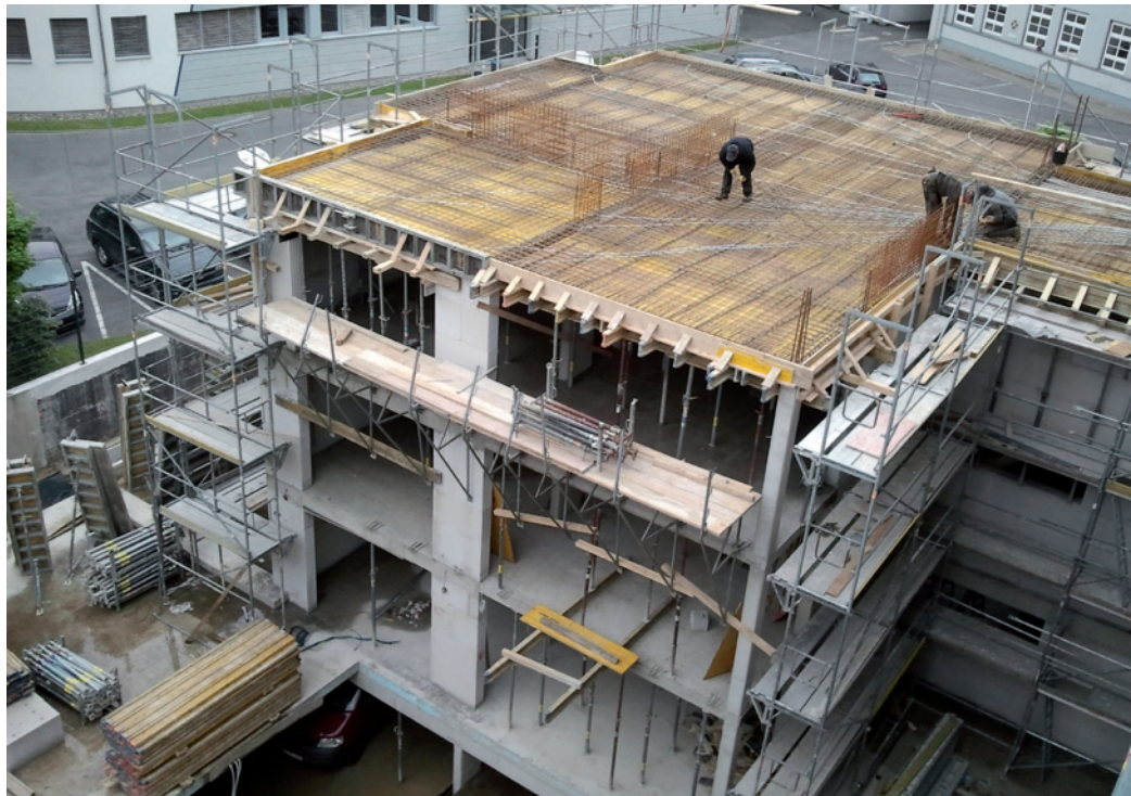
Neubau Hof / Rohbau
