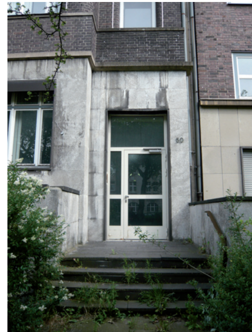
Bestand Zweigertstraße 50 Eingang
