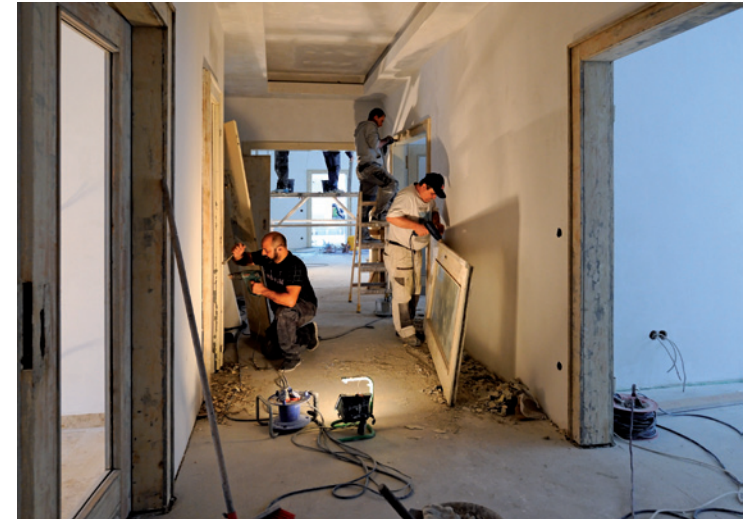
Baustelle Zweigertstraße 50, Holzsanierung
