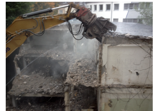
Abbruch der Anbauten im Innenhof
